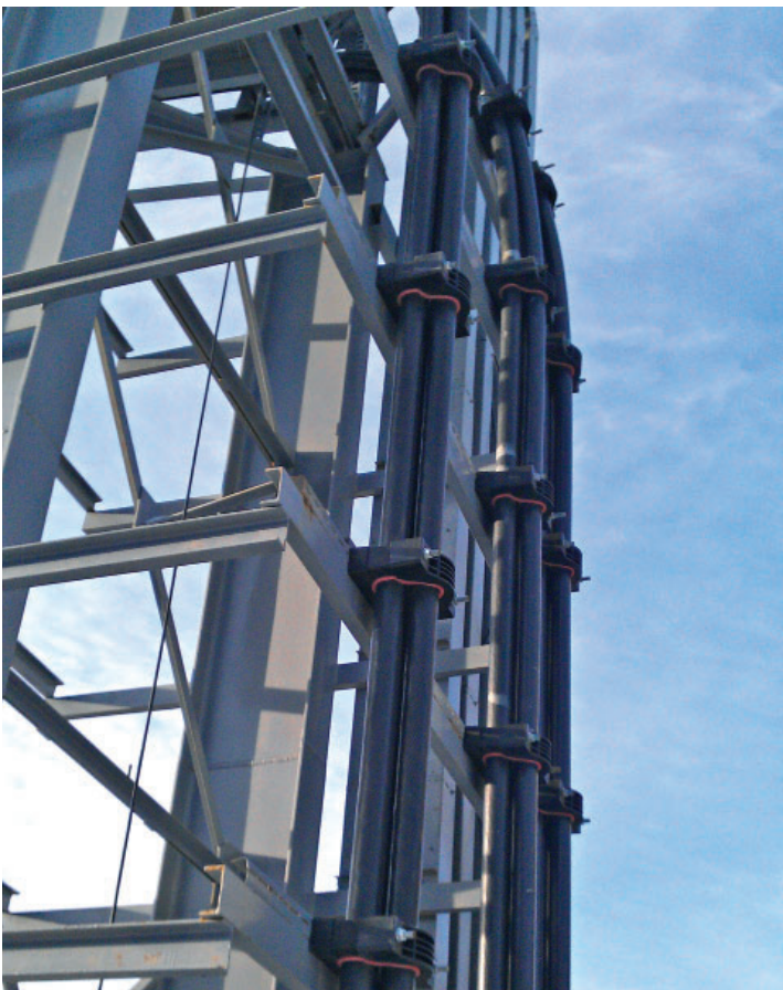
«Сызранская ТЭЦ» г. Сызрань. По эстакаде проложен кабель ПвВнг(А) 1х400/150 — 64/110 кВ производства ОАО «Кирскабель» в количестве 5 км.
