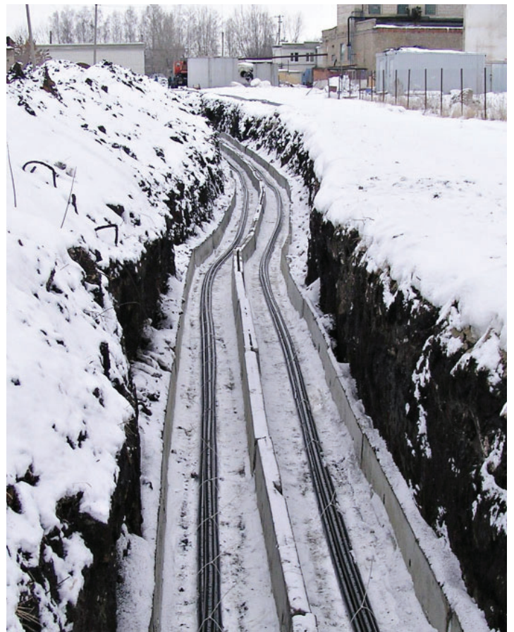
«Ливенская ТЭЦ», г. Ливны. Прокладка кабеля АПвПу2г 1х185/95 — 64/110 кВ производства ОАО «Кирскабель» в количестве 3 км.
